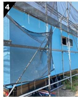
不燃材料のガルバリウム鋼板を外壁に装着し仕上げる。
