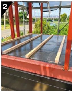
床面の発泡スチロール表面にポリウレアを塗布する。
