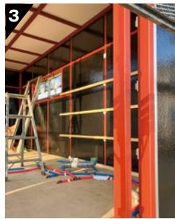
天井・壁面に発泡スチロールをはめ込みポリウレアを塗布。
